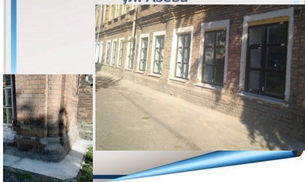
устройство отмостки со стороны ул. Азева
